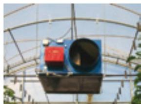
Pour le chauffage non destiné au confort des personnes la réglementation relative à l'éco conception (UE) 2015/1188 n'est pas applicable à la gamme des générateurs d'air chaud AGRI P qui pourront être équipés d'un brûleur fioul ou gaz.
